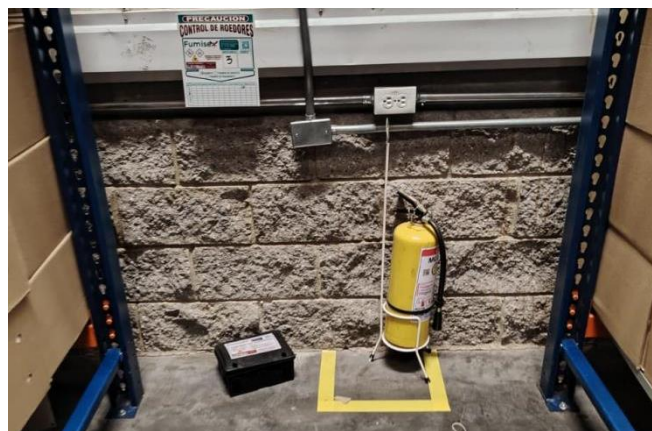
Foto 4. Evidencia trampa y extintor
